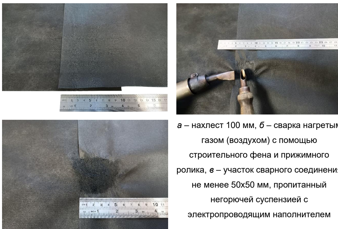
Рисунок 1 – Сварное соединение материала Контролит марки СП
