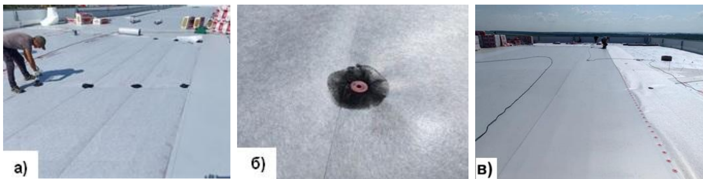
а – обработка суспензией мест механического соединения полотен слоя из материала Контролит НГ (допускается), б – крепление слоя к основанию с помощью телескопического крепежа, в - крепление полотнищ слоя Контролит и покрытия к основанию
