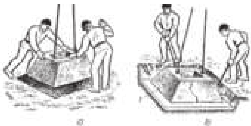
а) опускание на место; б) выверка
