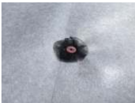
Рисунок 6 – Механическое соединение полотен электропроводящего рулонного материала
