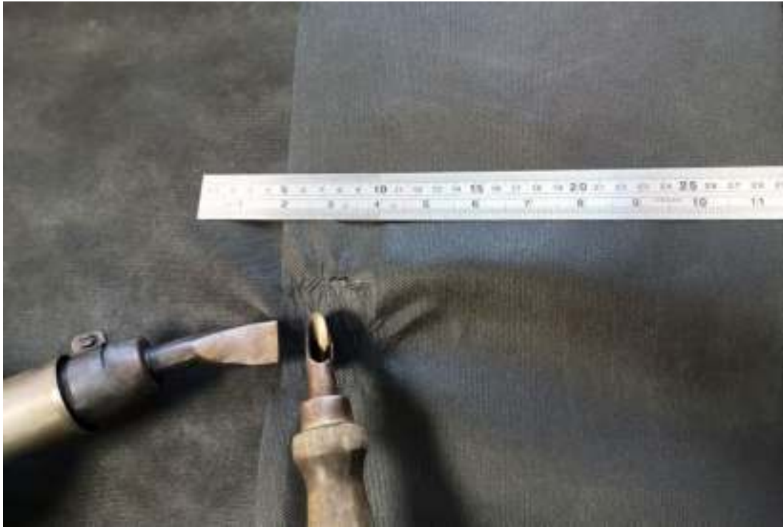
б – сварка нагретым газом с помощью строительного фена и прижимного ролика
